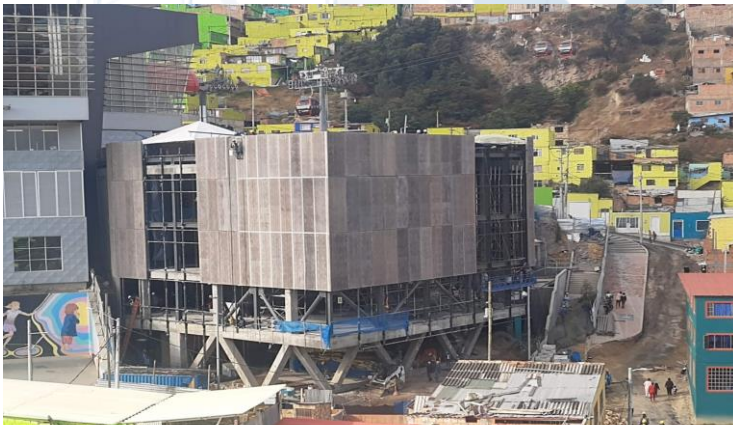
Supercade Manitas – Bogota D.C., Cliente : Concreto – Supervision Tecnica a Estructura Metalica
