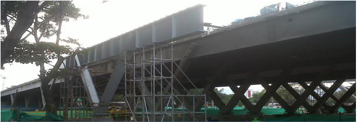
Ampliación puente vehicular Cra 1ra sobre la 70, Cali. Cliente – Fagar SQL 97
