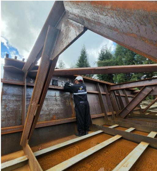
Puente Vehicular Conectante Av. 68 (Longitud: 390m Ancho:17m – Bogota), Cliente : Concreto – Control Calidad en Planta y Obra
