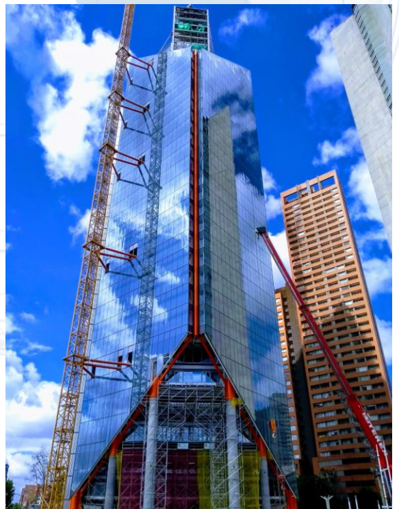
Centro Internacional Atrio – Bogotá D.C. – Cliente: Consorcio HST – Control Calidad Estructura Metalica
