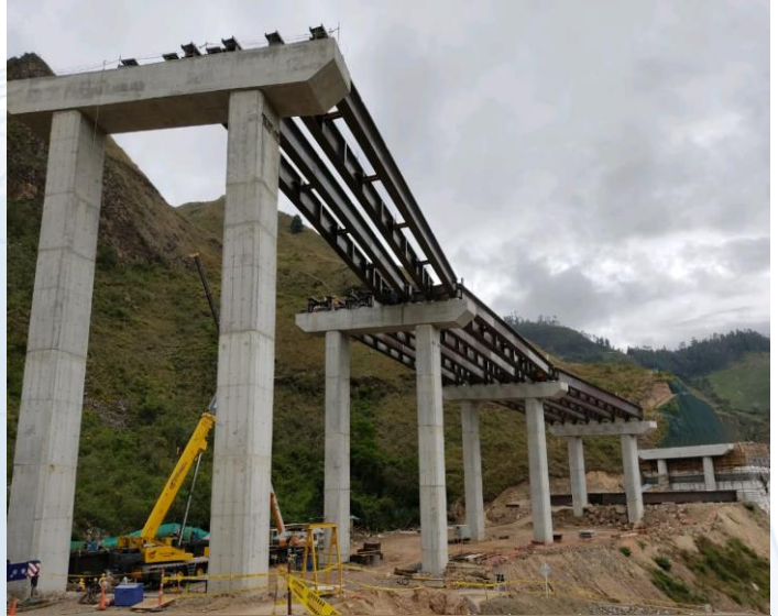
Puente Vehicular Vereda Tablon Alto (Longitud: 250m Ancho:21m – Pasto), Cliente: Consorcio SH – Control Calidad en Plantas y Obra
