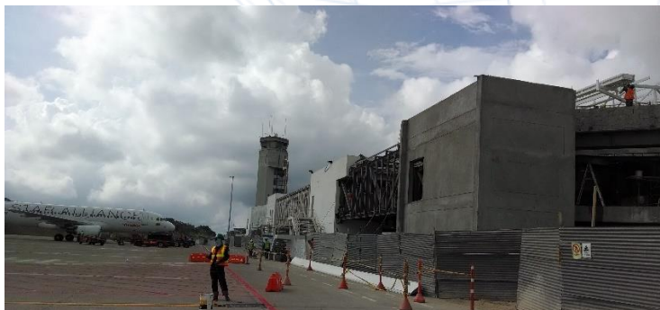
Remodelación Aeropuerto Internacional Camilo Daza, Cúcuta. Cliente – Emecon
